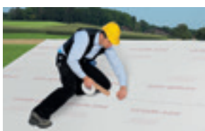
Aurutõkke paigaldamine konstruktsioonipealse soojustuse korral
