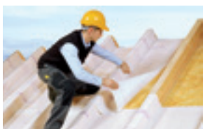
Aurutõkke paigaldamine: katuse renoveerimine väljastpoolt
