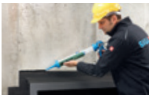
Lekete, pilude, läbijooksude tihendamine Lehekülg 39
