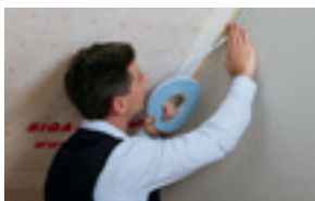
Aurutõkke ühendamine kivikonstruktsiooniga - krohvitud müüritis ja betoon
