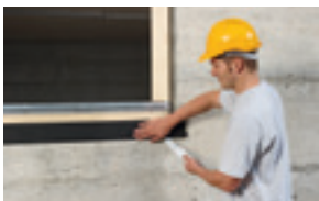
Akna ja kivikonstruktsiooni ühendamine Lehekülg 40
