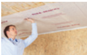
Aurutõkke paigaldamine lame-ja kaldkatustel
